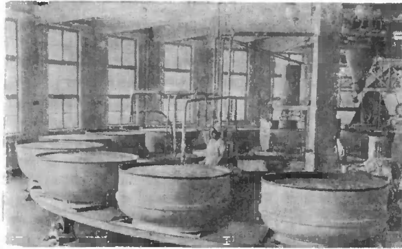
Московский хлебозавод-автомат. Дрожжевой цех
