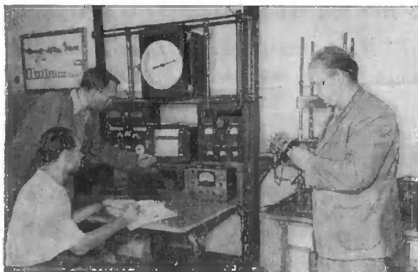
Институт автоматики Госплана Украинской ССР. Испытание аппарата для комплексной автоматизации установок непрерывного разлива стали
