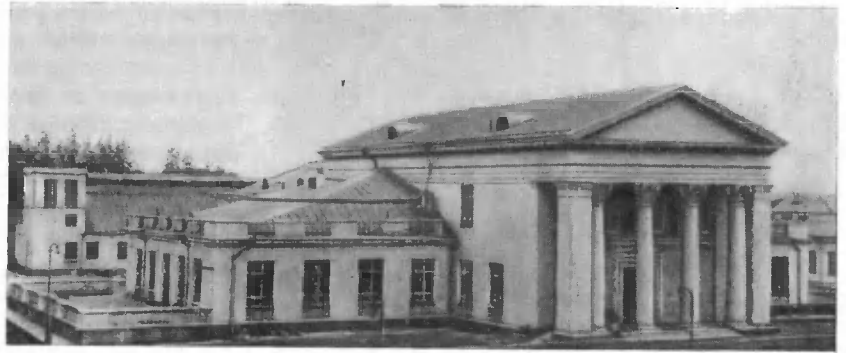
Рис. 1. Главное здание Станции искусственного климата
