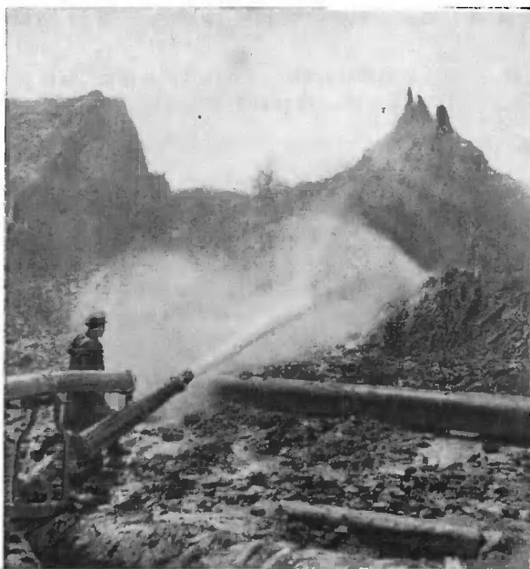
Кемерово. Кедровский угольный разрез. Гидро-монитор за размывкой грунта
